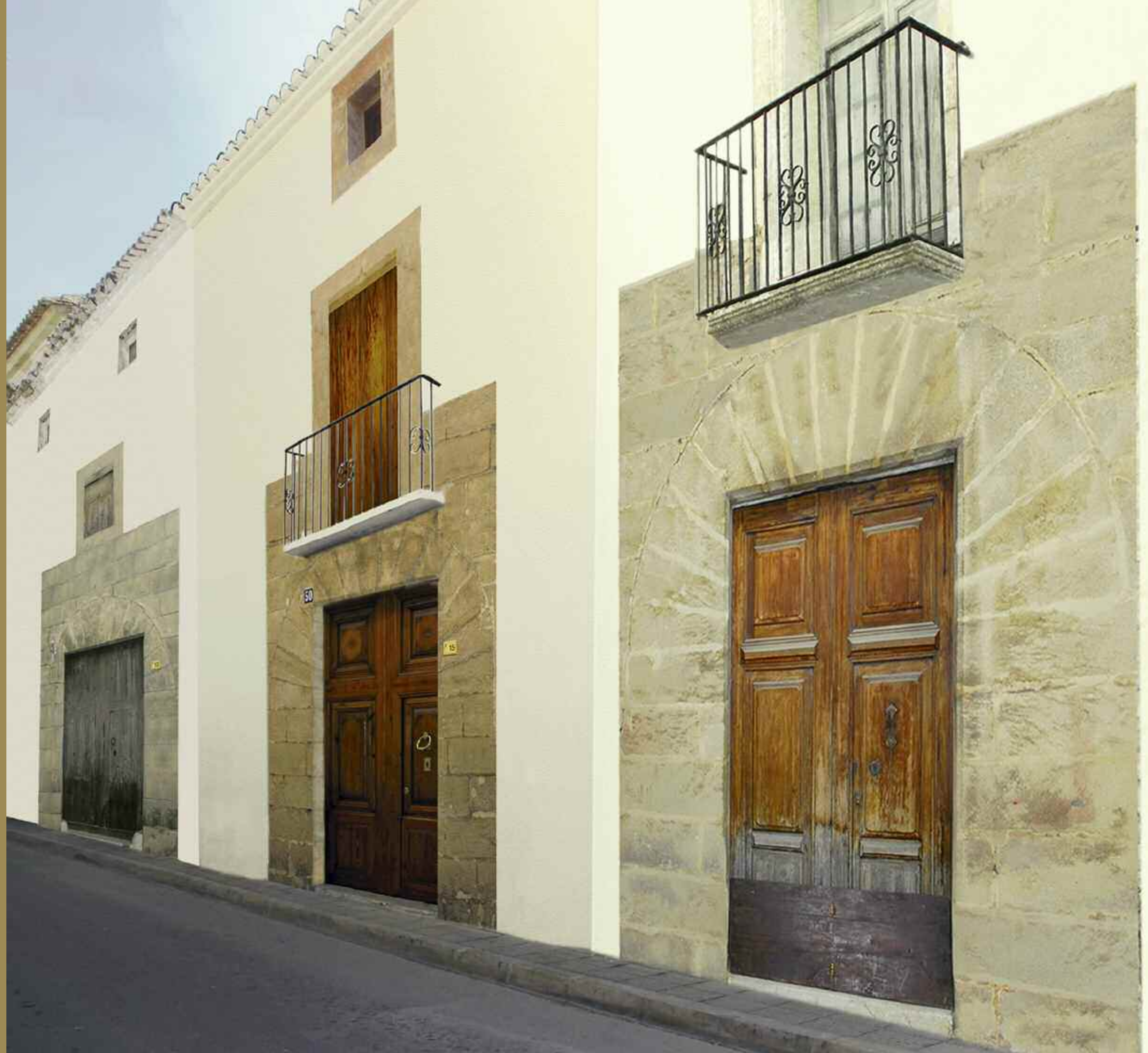
Carrer d'Avall (restauració)
